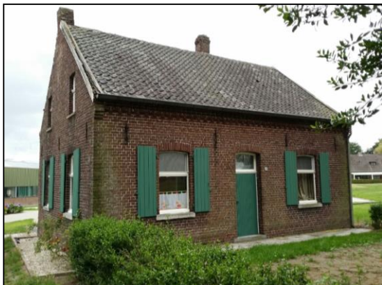
Foto bestaande situatie Roggelseweg 101 te Egchel
