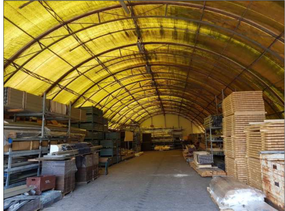
Figuur 10. Binnenzijde tunnelloods
