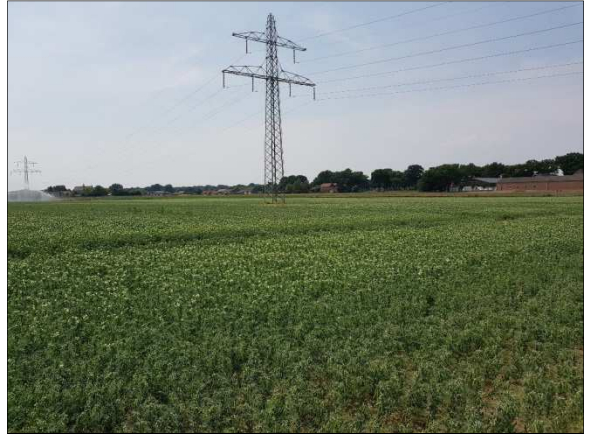
Figuur 6. Hoogspanningsmast aan noordzijde
