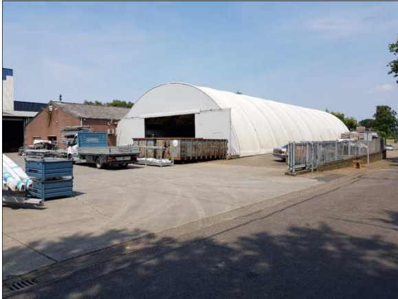
Figuur 9. Tunnelloods op locatie
