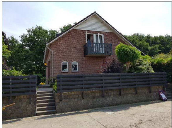
Figuur 14. Achterzijde woning
