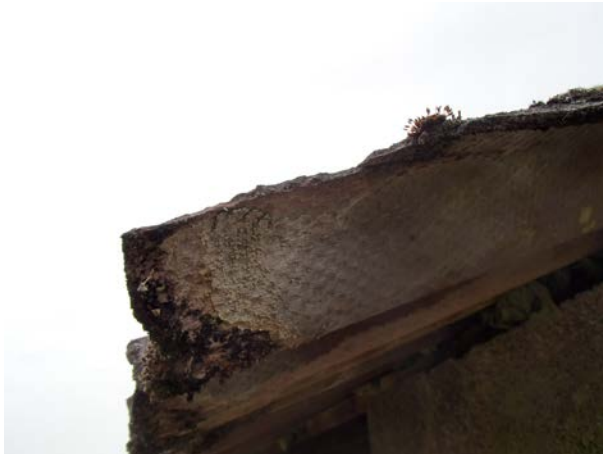
Foto 5. Asbestdak op onderzoekslocatie
