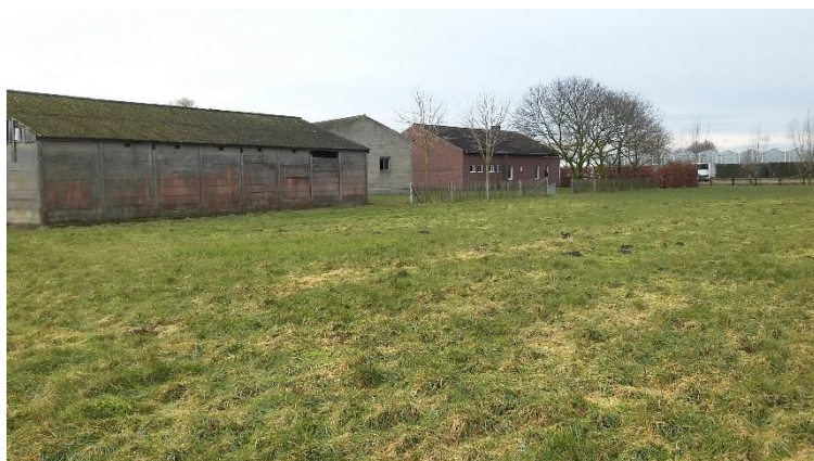
foto 5: onderzoekslocatie en Venweg 8a gezien vanuit het oosten (8 maart 2018)
