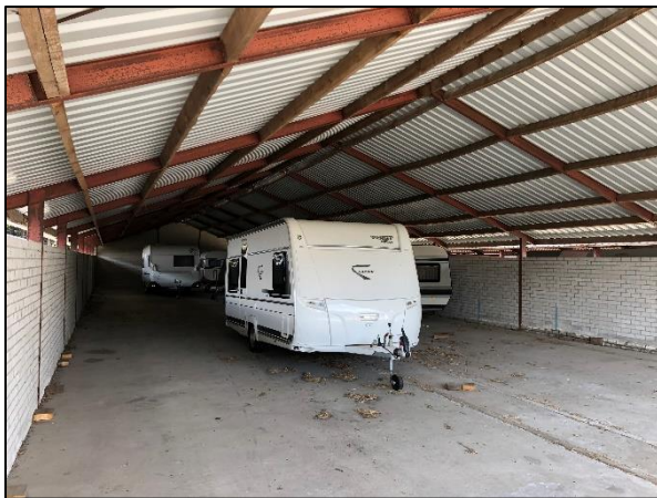
Afbeelding 10. Inpandige verbouwde voormalige stal tot caravanstalling
