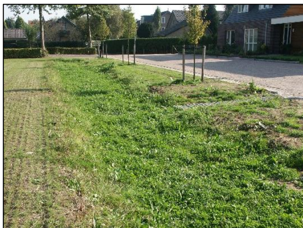
Afbeelding 8: Voorbeeld inpassing en werkwijze oppervlakkig infiltratieveld (bron: afkoppelnota gemeente Nijmegen)
