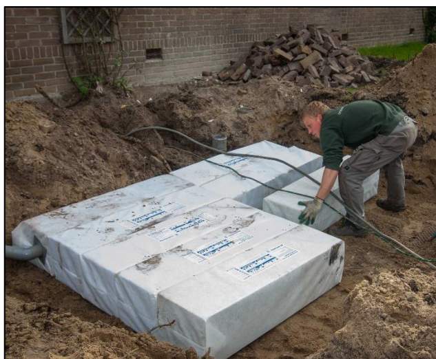
Afbeelding 9: Voorbeeld inpassing en werkwijze ondergrondse infiltratiekrat/put (bron: Amsterdam rainproof)
