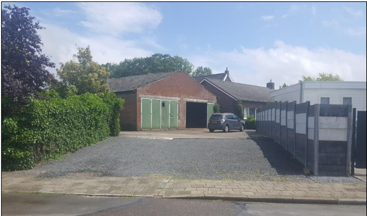
Afbeelding 5. Zicht op een van de voormalige bedrijfsgebouwen vanaf de Beeselseweg
