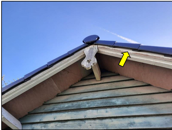
Figuur 15. Kantpannen die toegang verlenen tot de ruimte onder het dak.
