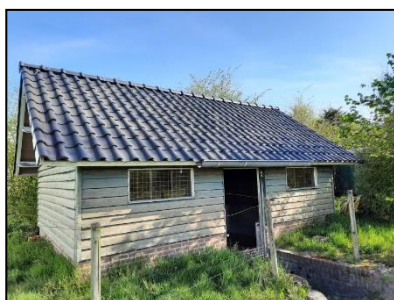
Figuur 4. Stal met dakpannen zadeldak, kijkrichting noord.
