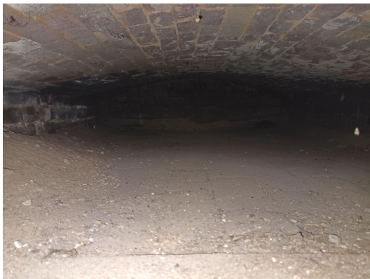
Binnenzijde oven bakhuisje
