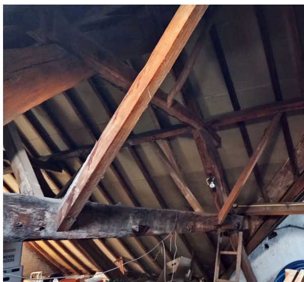
Verbeterd-hollandse spant-dakconstructie
