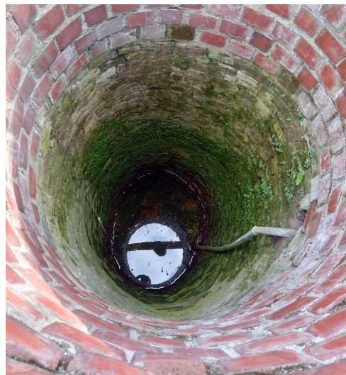
Metselwerk binnenzijde waterput
