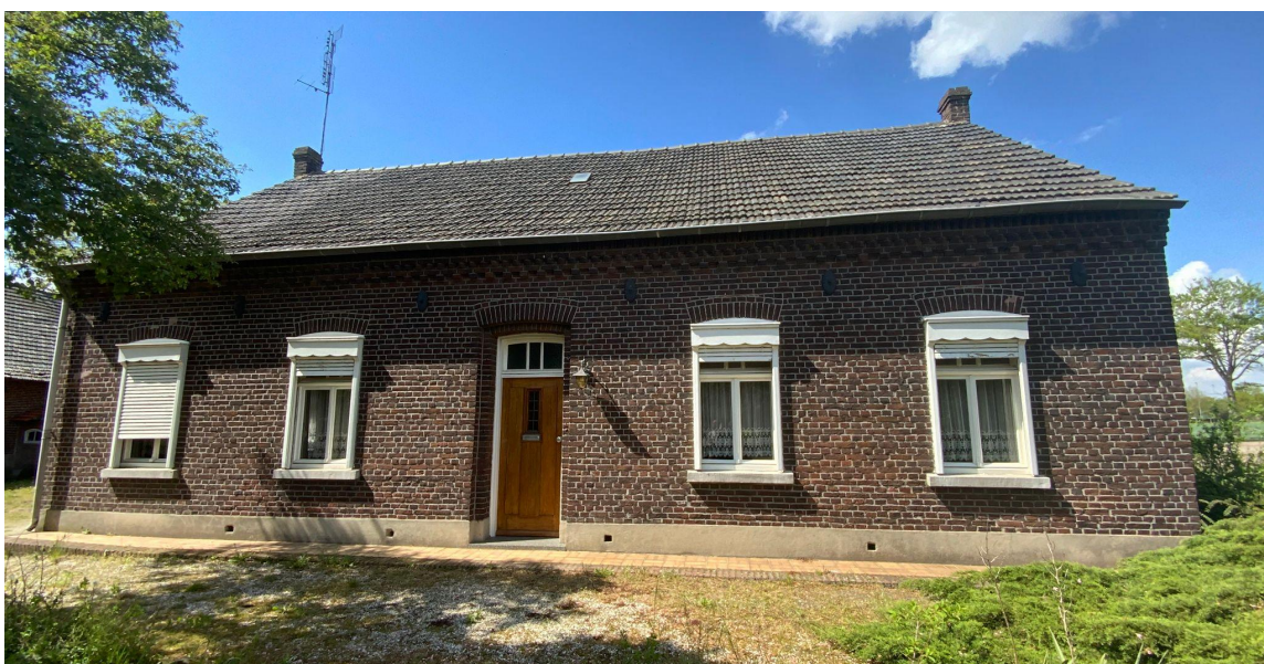
zuidoostelijke gevel woonhuis
