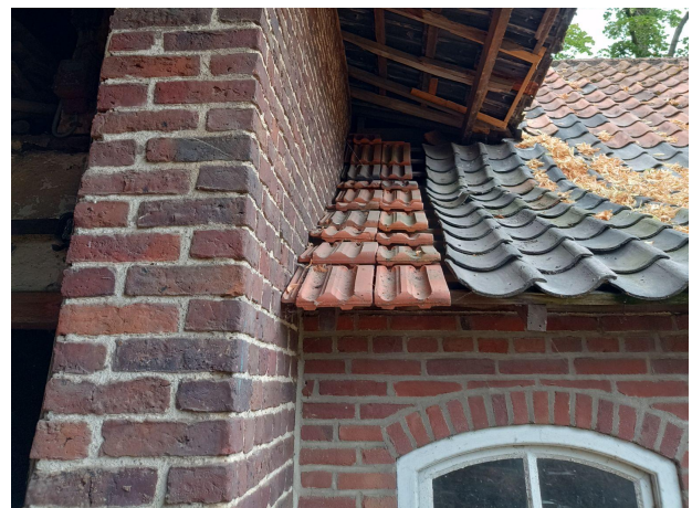
dak varkensstal zijde binnenplaats
