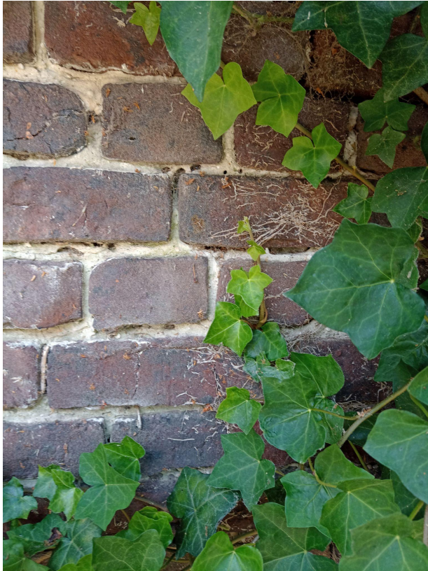
Detail metselwerk, met klimop en nestgaten
