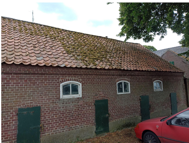
Varkensstal vanaf de Heezestraat Bouwkundige staat
