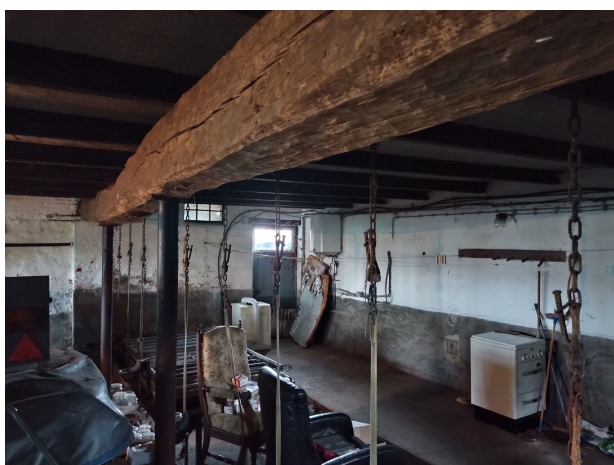
Eikenhouten balk draagconstructie Koeienstal
