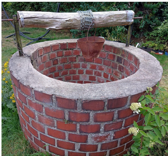
Waterput met gerenoveerde trommel
