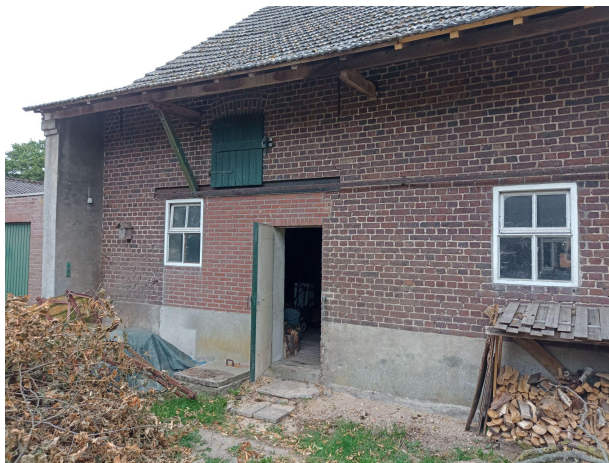
restanten schuifpoort gevel schuur binnenplaats Hergebruikte balken dakconstructie
