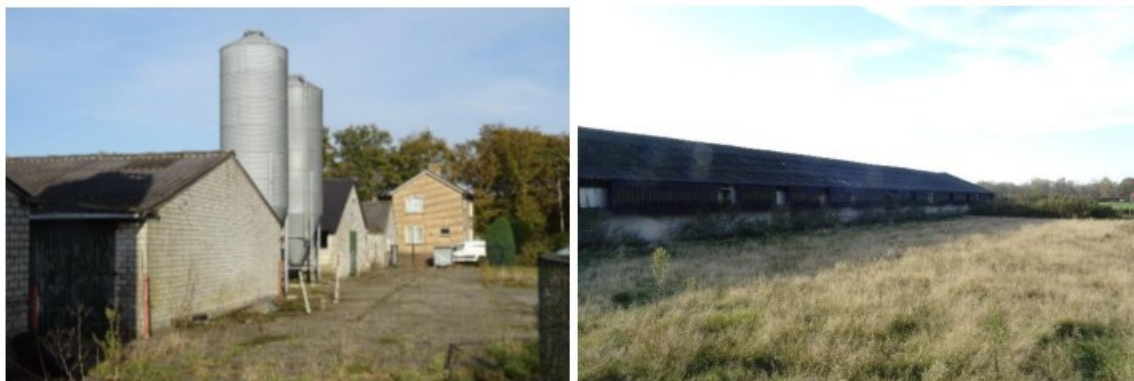
Afbeelding 3 t/m 6: De aanwezige te slopen stallen op de kavel. Bron: BNL advies, datum: 10-11-2021
