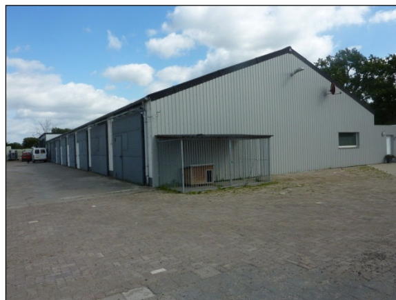
Figuur 5: Achterzijde bestaande hal
