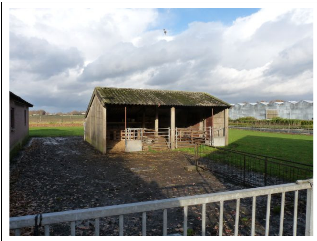
Foto 3. Te slopen open kapschuur, oostelijk deel onderzoekslocatie.
