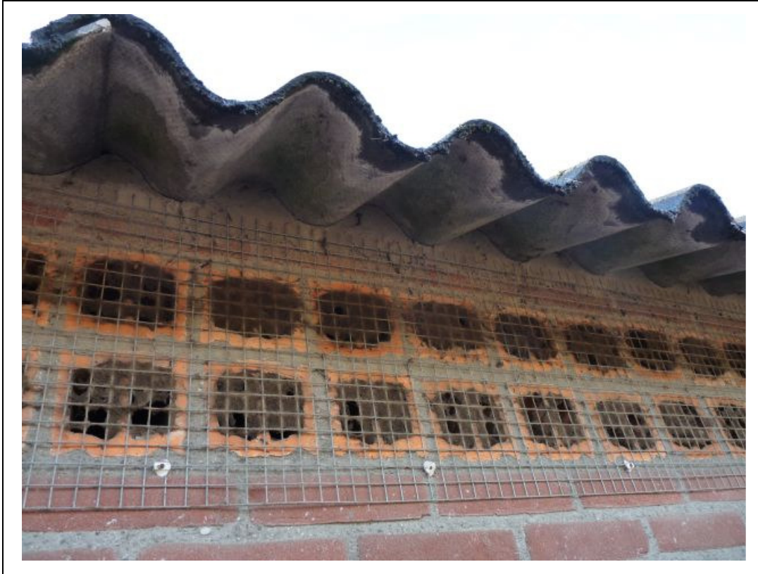
Foto 5. Openingen in de slopen schuur zijn grotendeels afgedicht.
