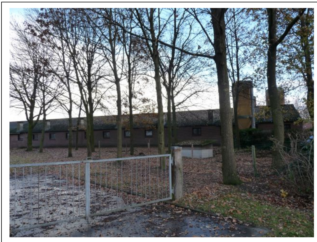
Foto 1. Bomen en te slopen varkensschuur, westelijk deel onderzoekslocatie.
