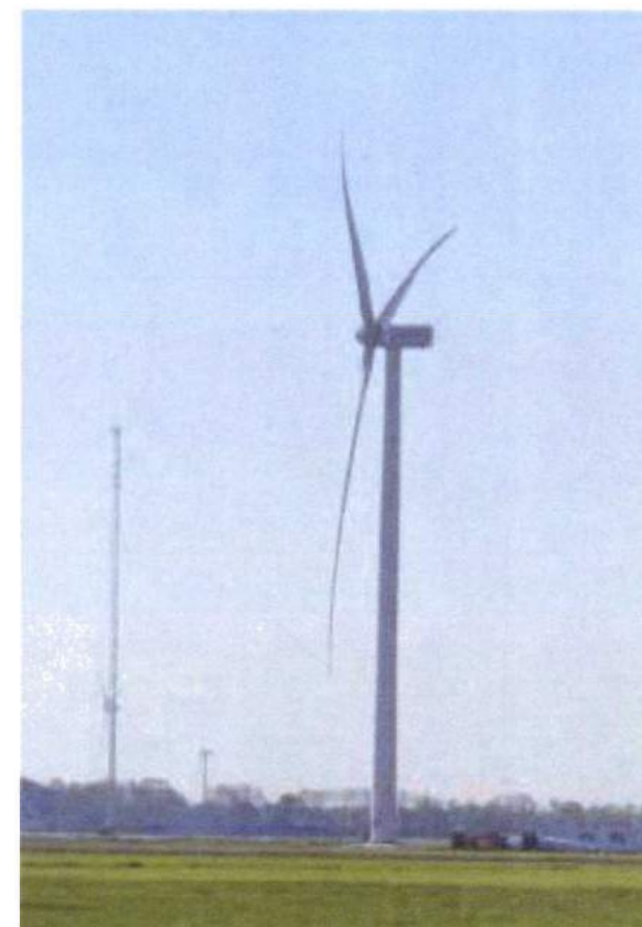
fig 7) GE 2.75-120. Tiplaagte 25 meter
