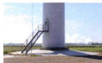
Voorbeeld oplopende betonnen mastvoet in de Wieringermeer
