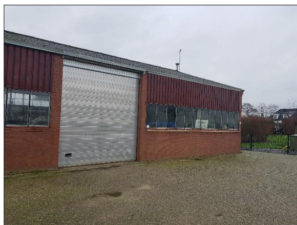
Figuur 9. Te slopen opslagloods zuiden plangebied
