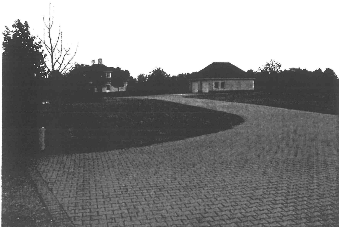
Foto 11: De oude locatie aan de Napoleonsbaan met huis en garage (rechts werden vroeger de vrachtwagens gestald)
