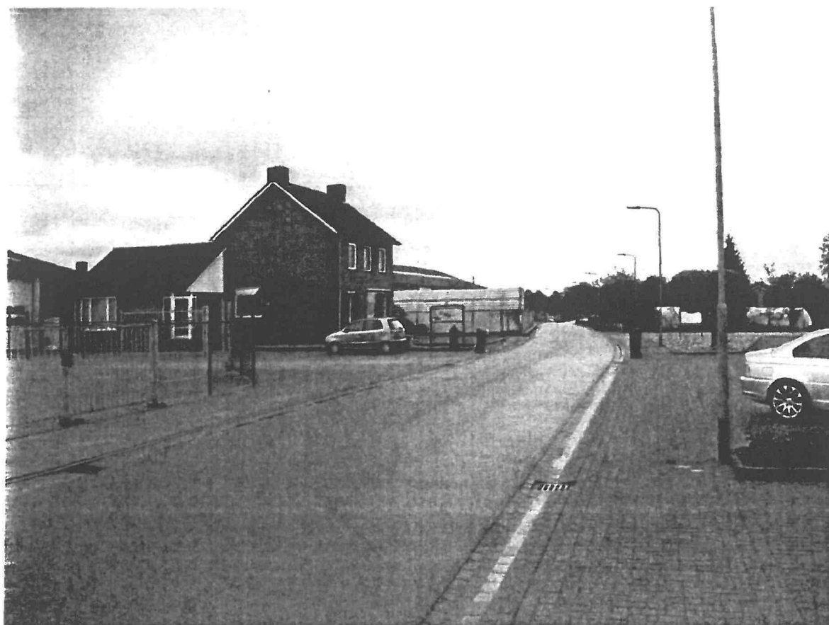
Foto 8: Aansluiting bedrijf (rechts achter bord) op de Kieënweg
