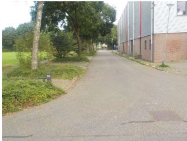
Foto 10. Minister Calsstraat asfalt
