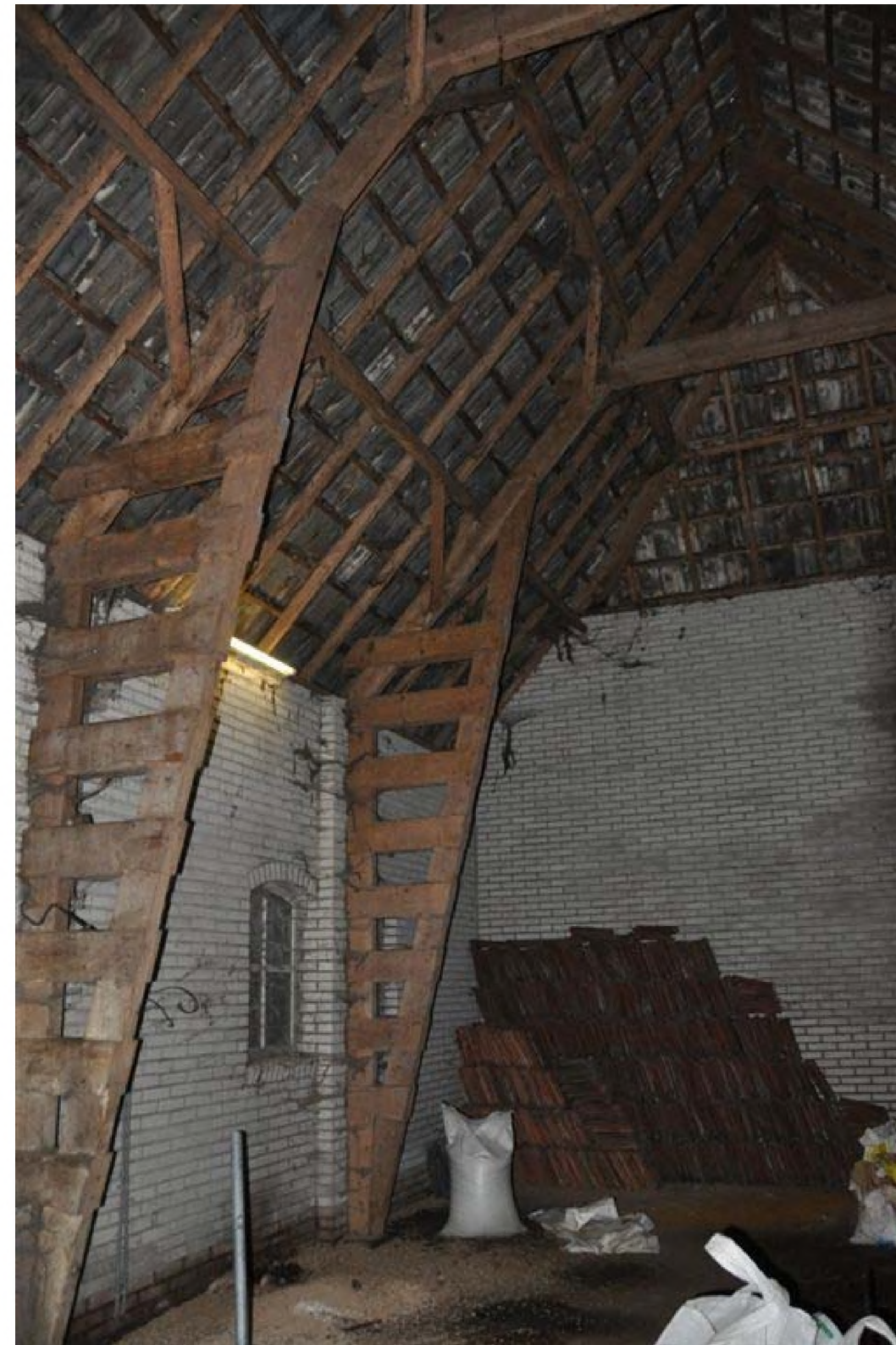
Interieur wederopbouwschuur Haanwijk 1
