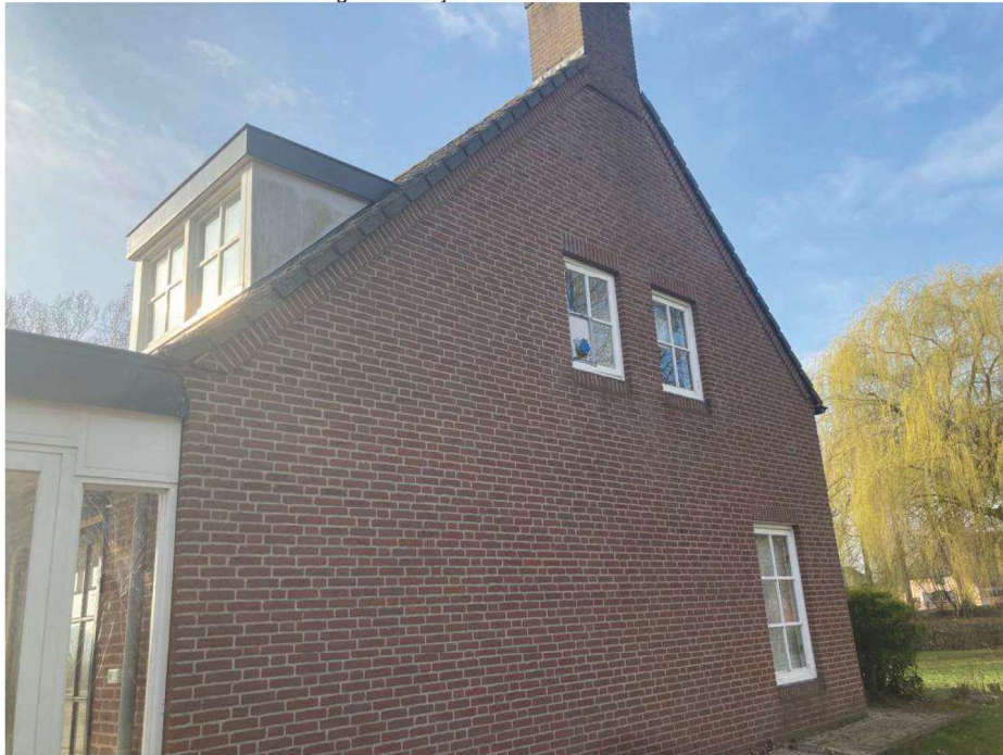
• Afbeelding 4: buitenzijde woonhuis
