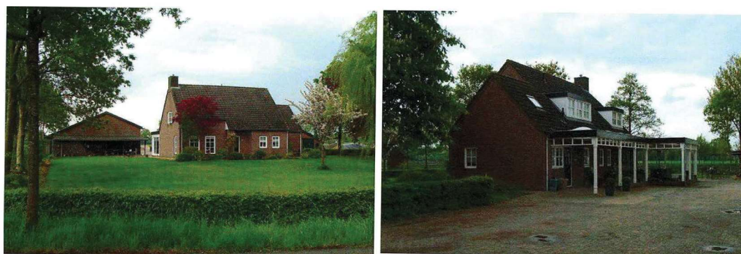
Afb. 4 Bestaande toestand woonhuis. Links: voorzijde. Rechts: achterzijde.
