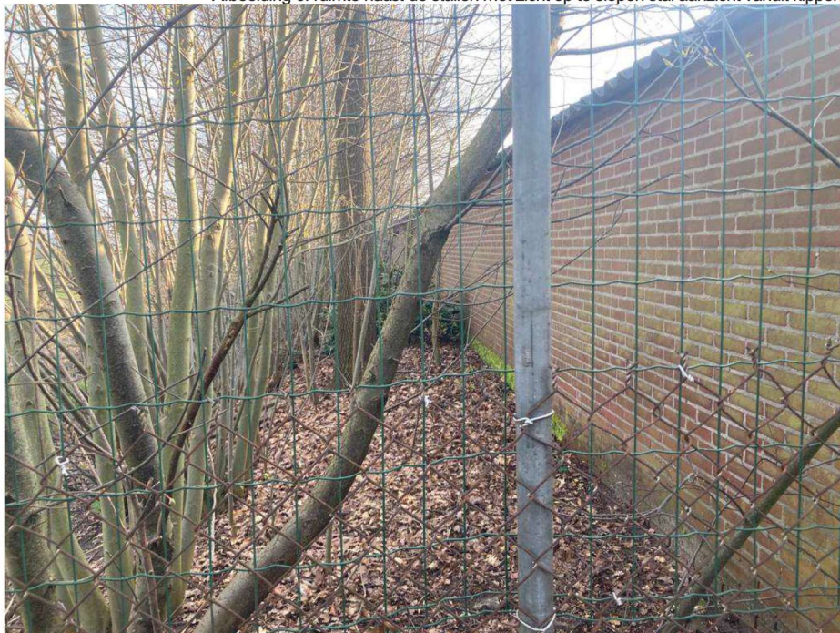
• Afbeelding 6: ruimte naast de stallen met zicht op te slopen stal aanzicht vanuit kippenren
