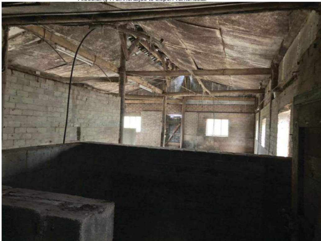
• Afbeelding 7: binnenzijde te slopen varkensstal
