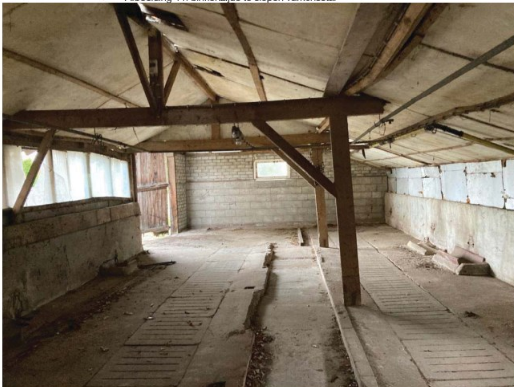
• Afbeelding 11: binnenzijde te slopen varkensstal
