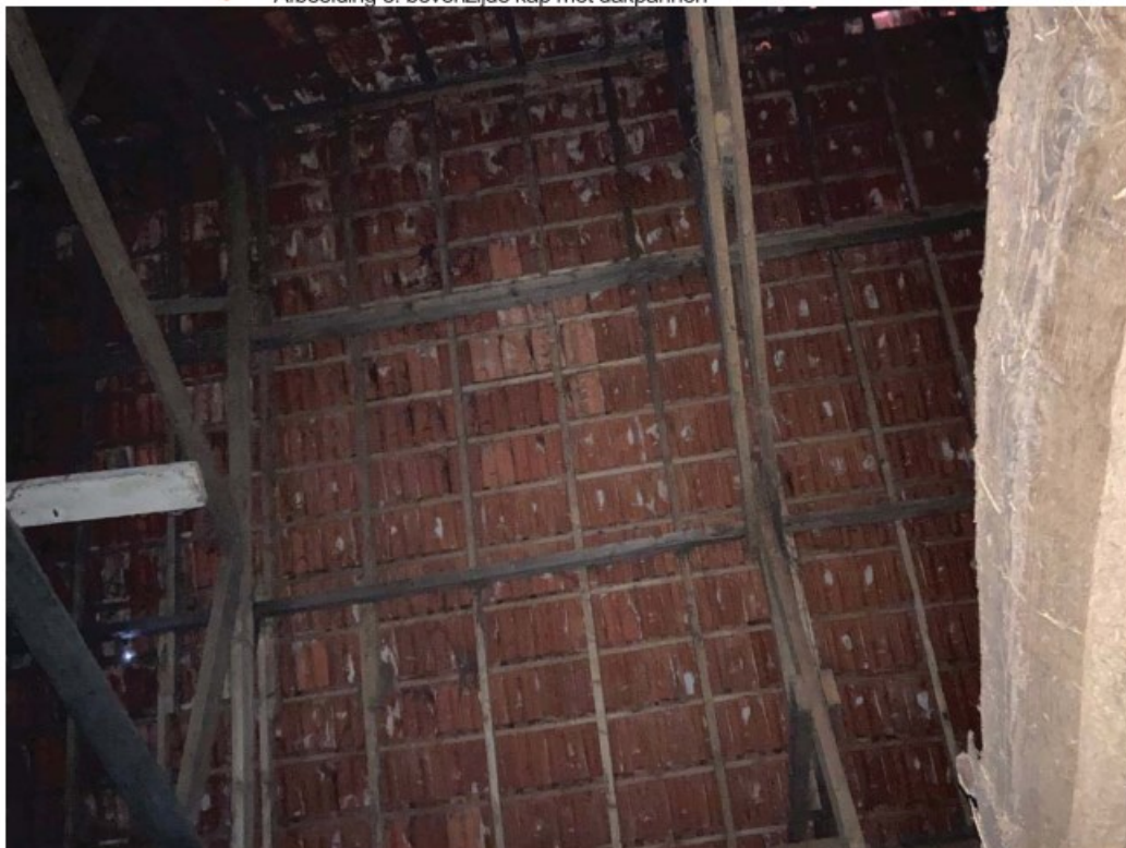
• Afbeelding 5: bovenzijde kap met dakpannen
