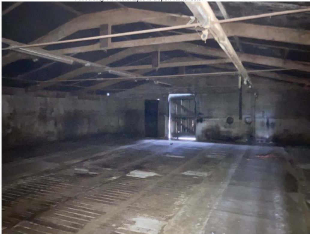
• Afbeelding 14: binnenzijde te slopen varkensstal
