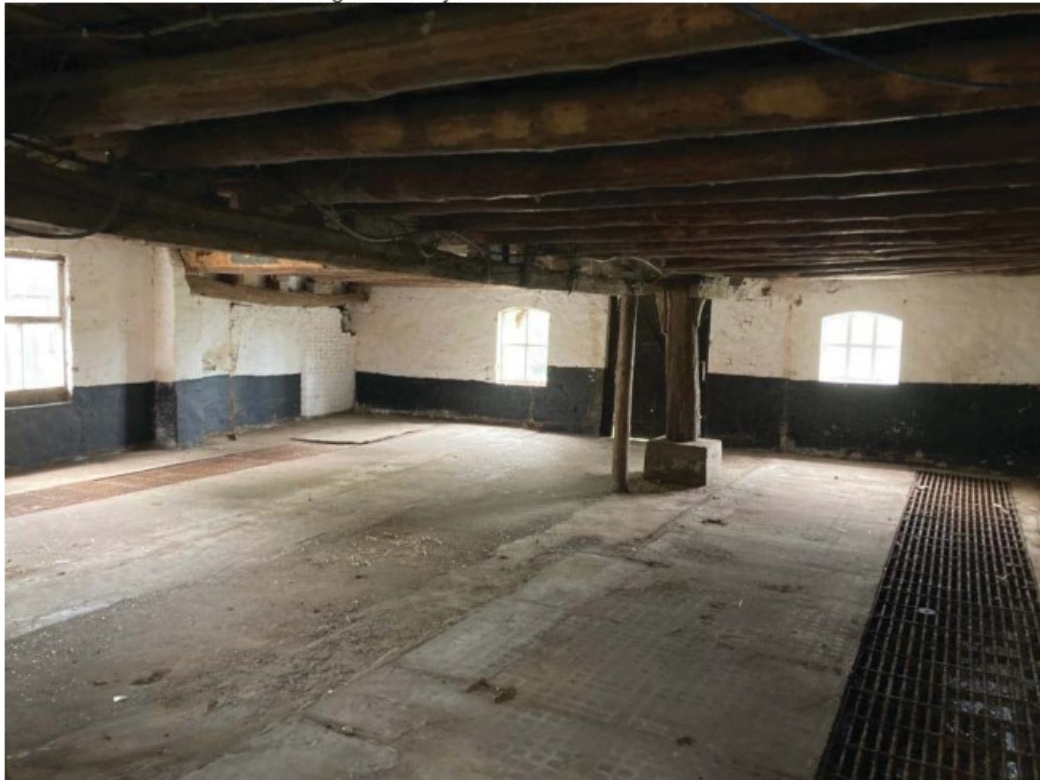
• Afbeelding 3: binnenzijde woonhuis
