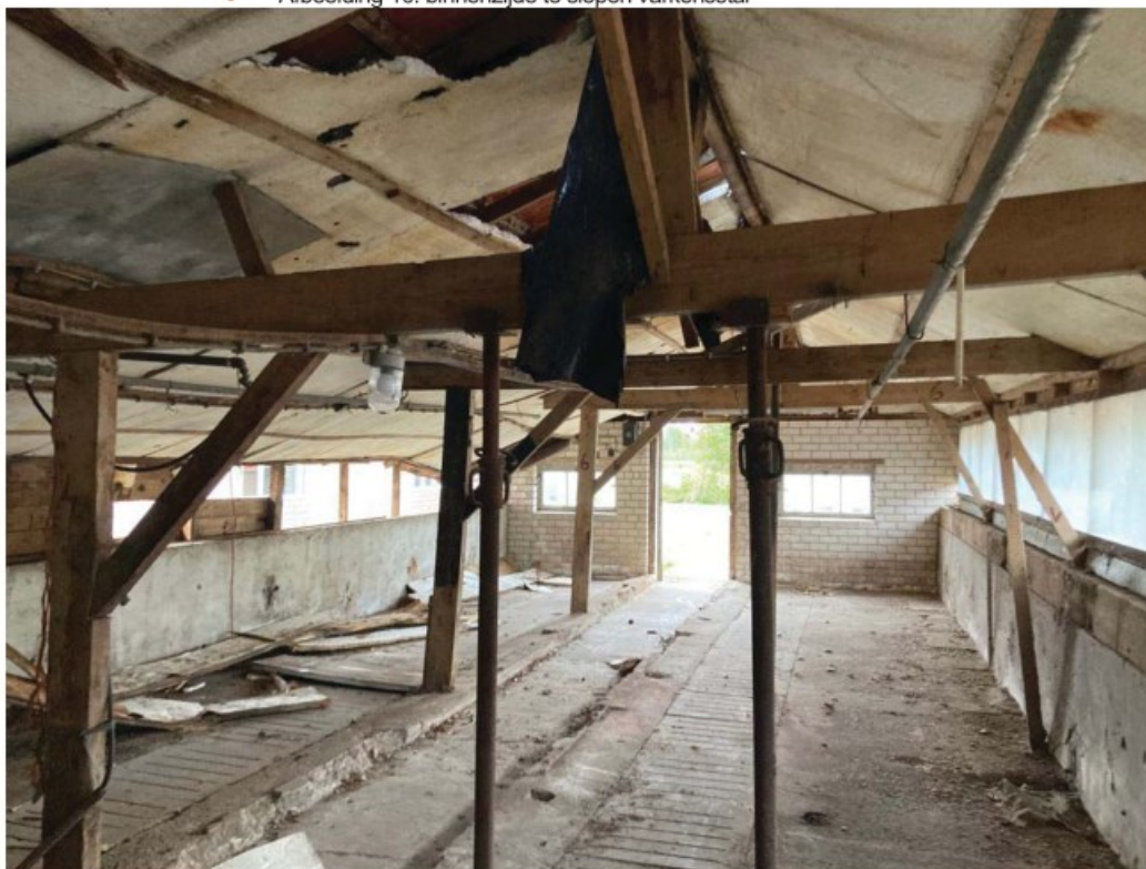
• Afbeelding 10: binnenzijde te slopen varkensstal
