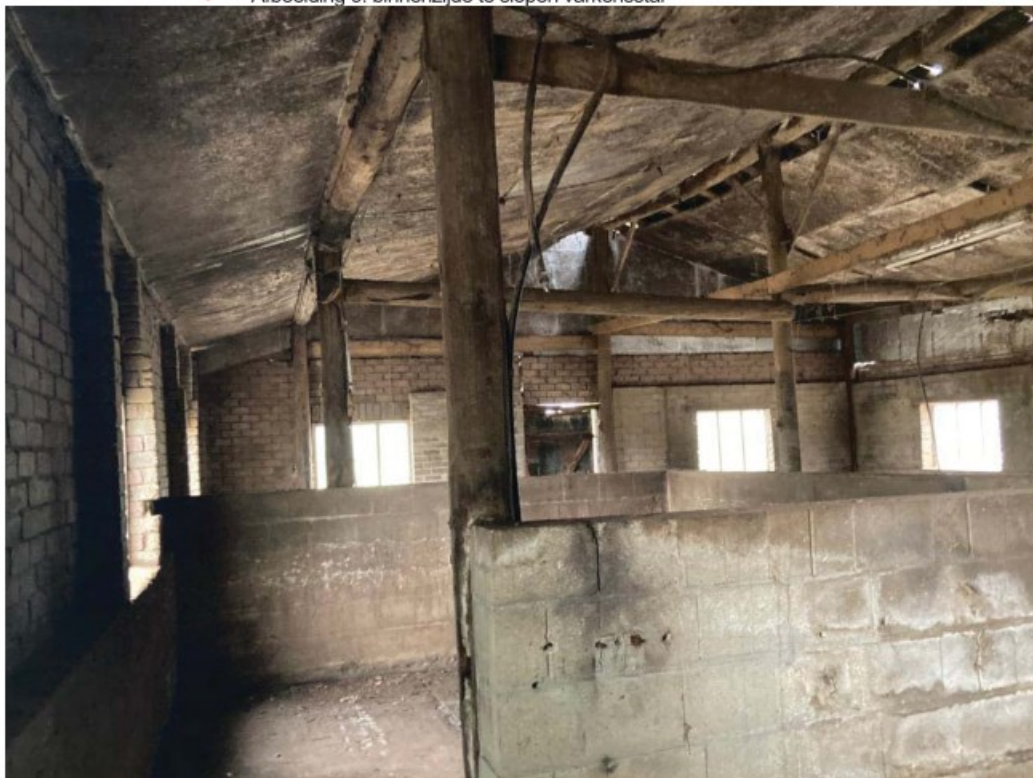
• Afbeelding 9: binnenzijde te slopen varkensstal
