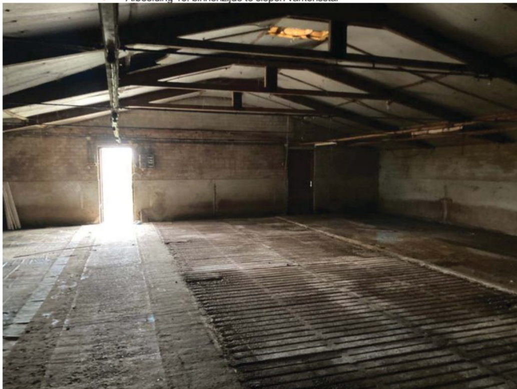
• Afbeelding 15: binnenzijde te slopen varkensstal
