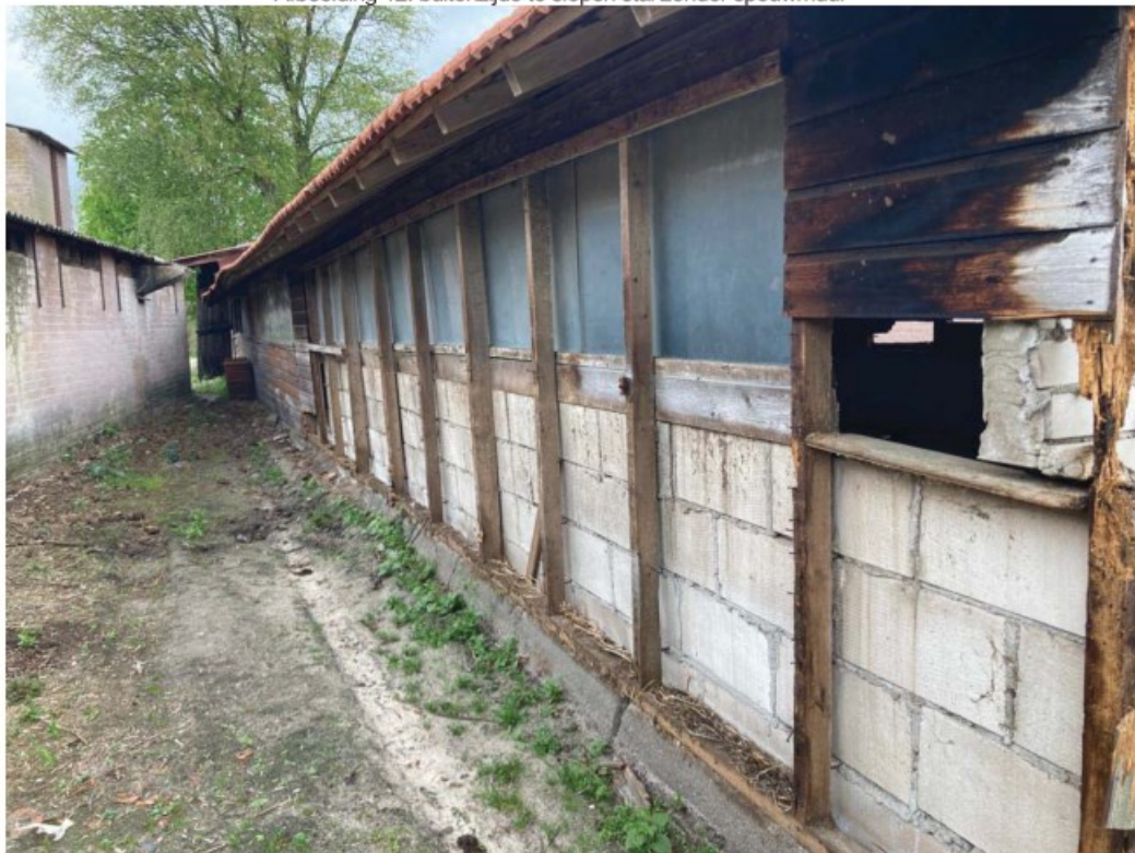
• Afbeelding 12: buitenzijde te slopen stal zonder spouwmuur
