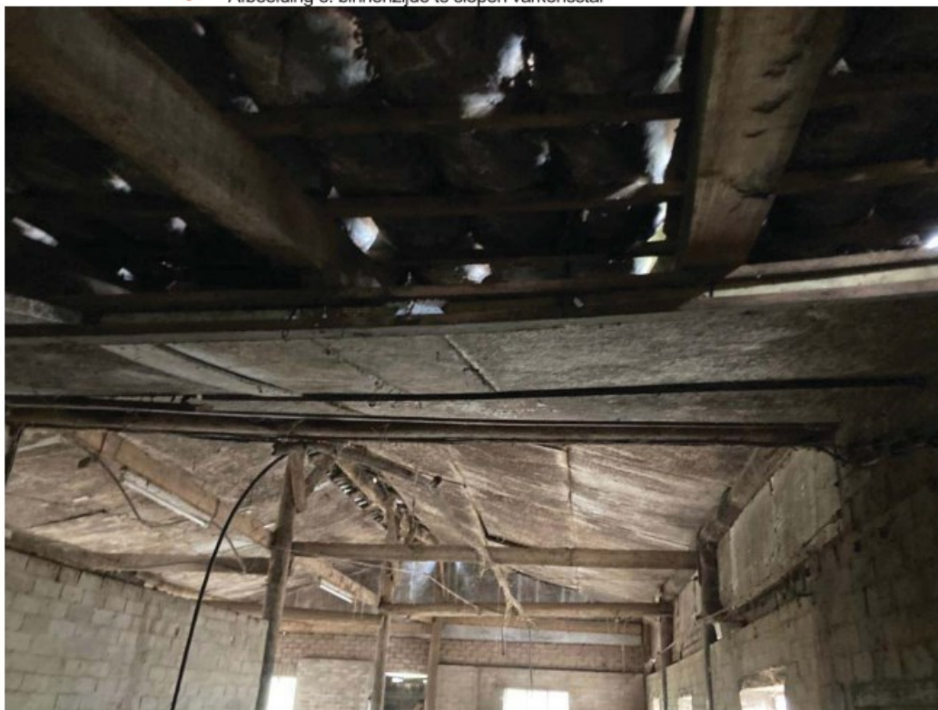
• Afbeelding 8: binnenzijde te slopen varkensstal
