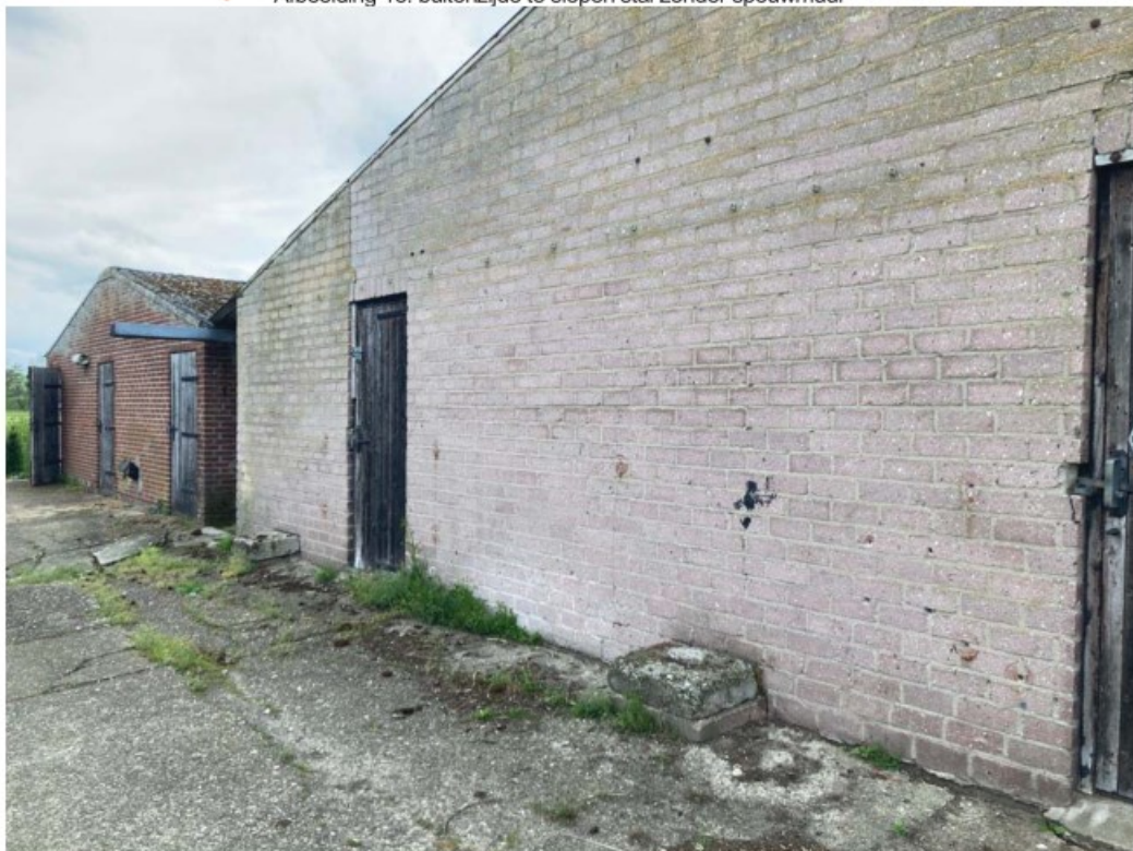
• Afbeelding 13: buitenzijde te slopen stal zonder spouwmuur
