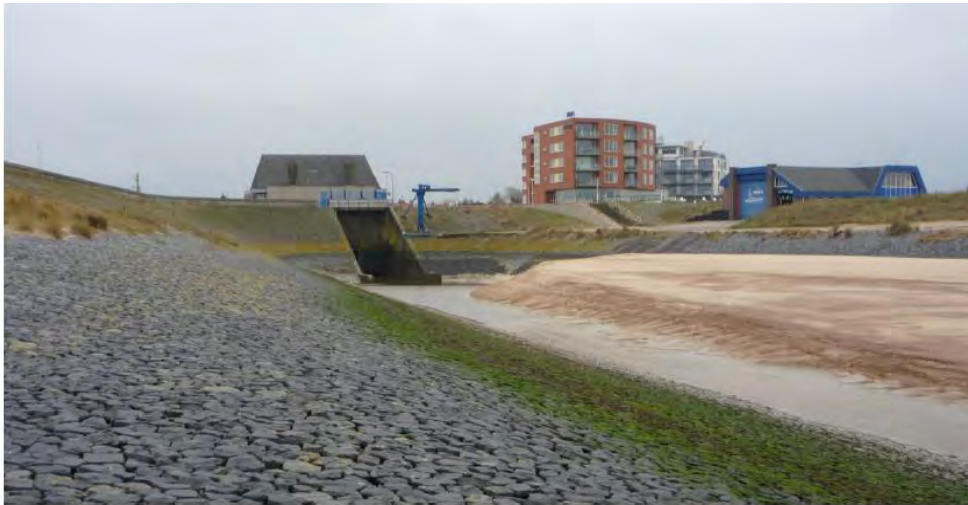
Figuur 5.4 Suatiegeul met gemaal [Svašek Hydraulics, 2012]
