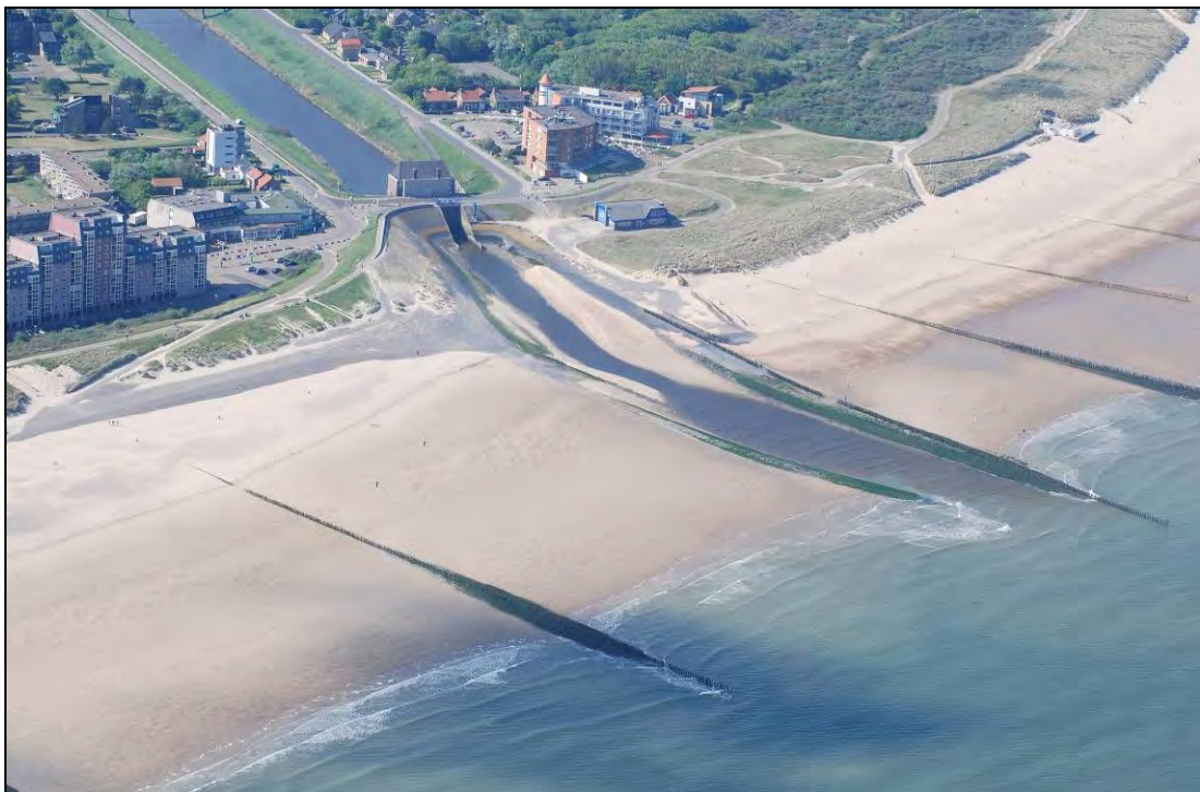
Figuur 2.2 Luchtfoto gemaal en strekdammen vanaf zee [Waterschap Scheldestromen, 2011]
