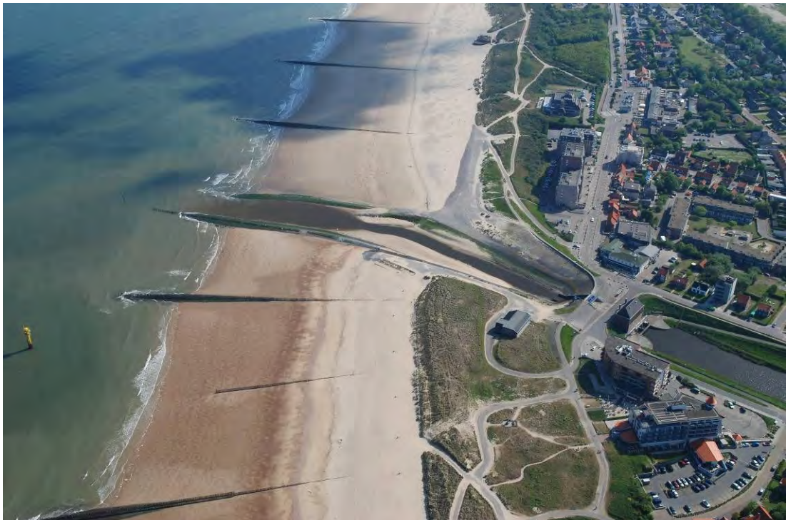
Figuur 2.1 Luchtfoto gemaal en strekdammen [Waterschap Scheldestromen, 2011]
