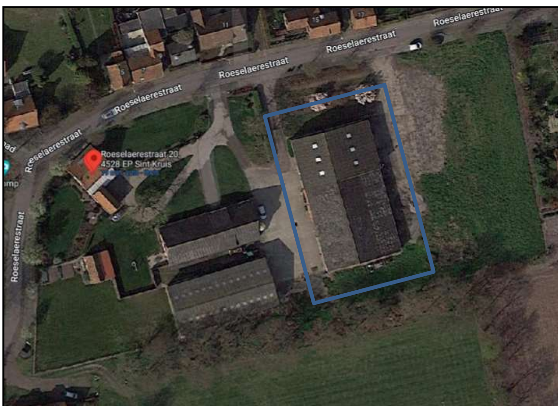
Figuur 2: Foto bestaande situatie te slopen schuur
