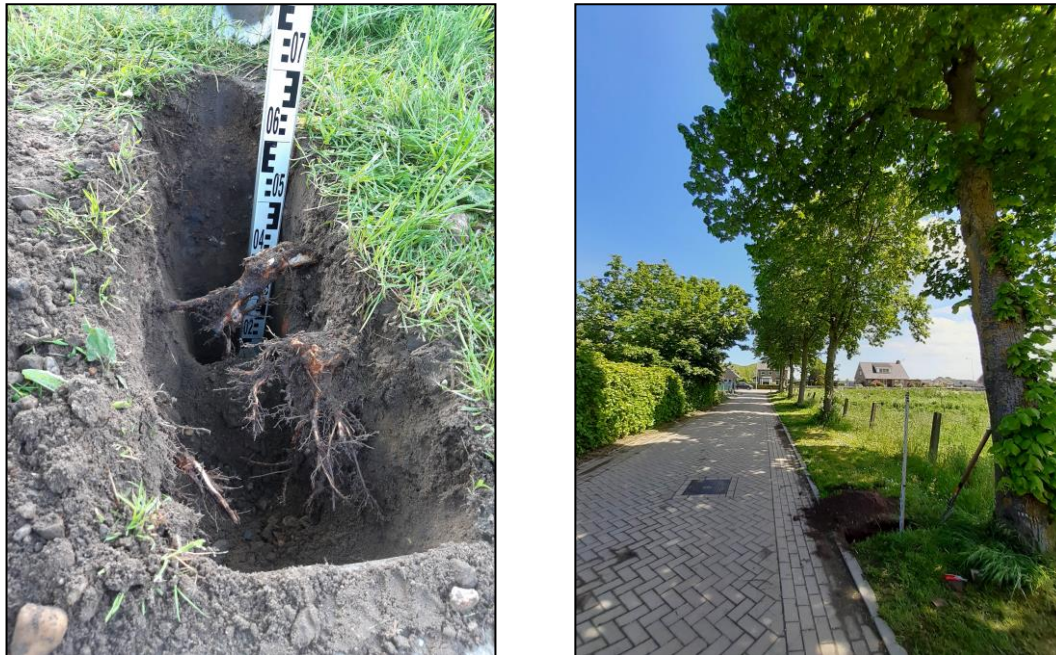
Figuur 6: Opname bodemprofiel aan de rand van het wegdek ter plaatse van boom 6. Foto links wortelstompen nabij de rijbaan.
