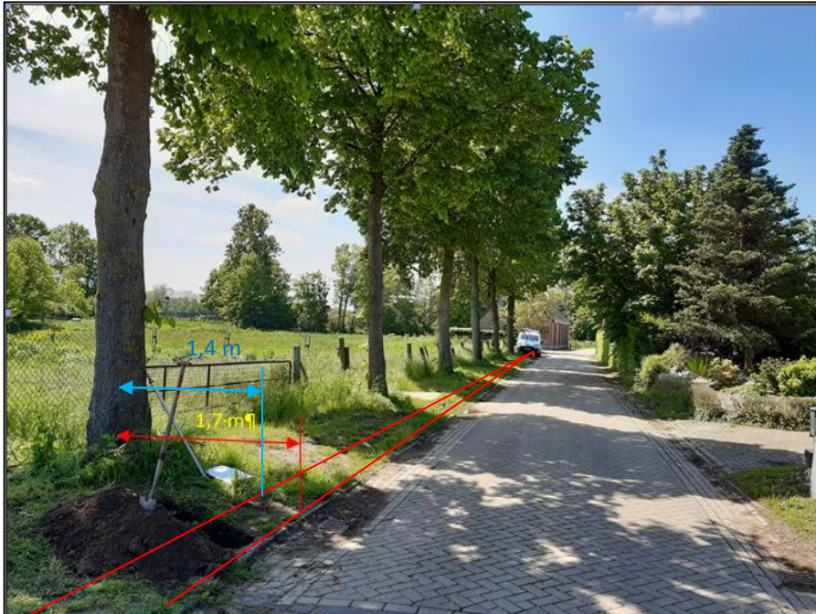
Figuur 3: Verbreding van de rijbaan. De afstanden tussen het hart van de bomen en de rand van de verharding varieert van 1,55 m tot 1,7 m.
