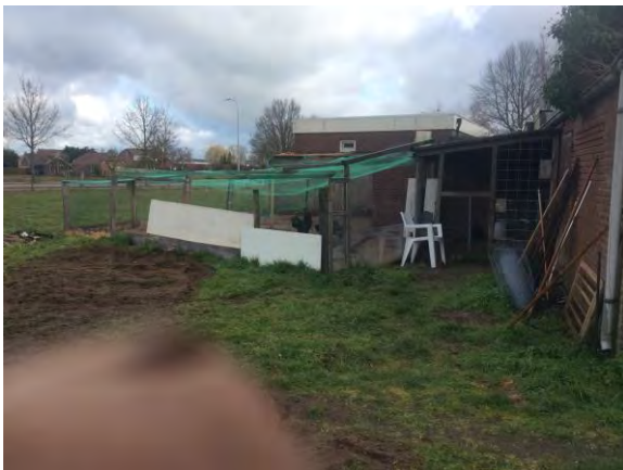
Figuur 3: Overzichtsfoto bebouwing
