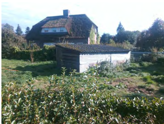
Figuur 8: Asbestverdachte bebouwing
